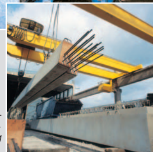
POUTRES DE STRUCTURE. Béton autoplaçant.
