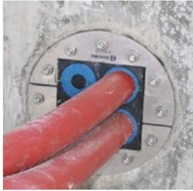
Les solutions Roxtec UG™ sont idéales pour les câbles entrant par les fondations. Elles offrent un excellent maintien du câble, empêchent les inondations et préviennent de l'humidité risquant d'endommager les équipements.
