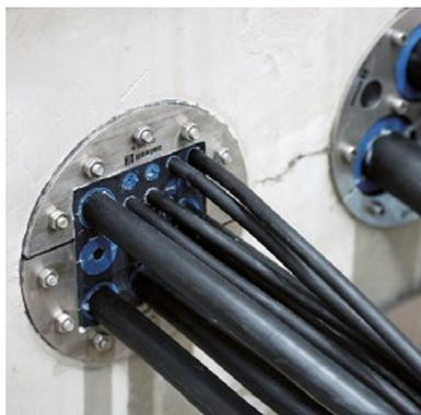
Les solutions Roxtec UG™ (applications souterraines) pour câbles et tuyaux sont développées pour protéger votre site contre les infiltrations environnementales, dans des conditions normales et en cas d'inondation. Leur capacité à résister à la flexion d'un câble, liée à une charge et à la force de courbure d'un câble, contribue à rendre ces solutions résistantes à la pression constante de l'eau et à vous protéger contre le risque de décharge partielle.
