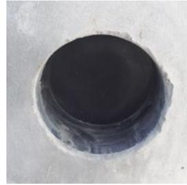
Le manchon knock-out de Roxtec offre une capacité de réserve et assure l'étanchéité avant l'acheminement des câbles.
