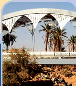
Pont de Ticherihine, Wilaya de Ghardaia
