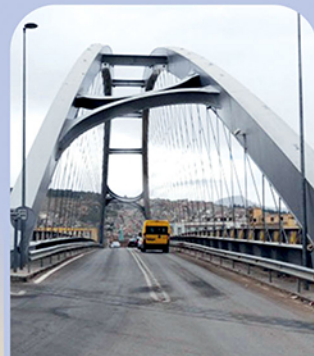
Pont S-Voies ferées, Wilaya de Souk Ahras
