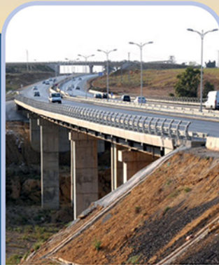
Viaduc RN 36, Ouled Fayet, Wilaya d'Alger
