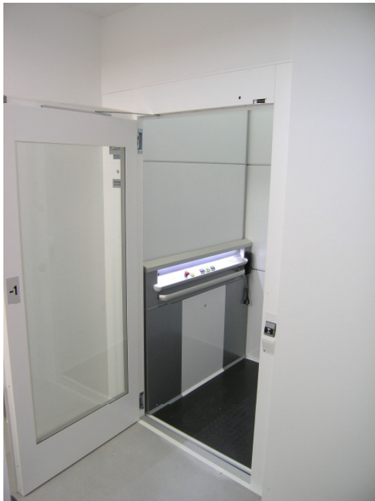
Lifteinbau in bauseitigen, gemauerten Schacht in Mehrfamilienhaus
