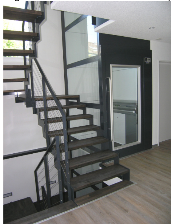
Einbau in Einfamilienhaus mit einseitig verglastem Schacht neben offener Treppe
