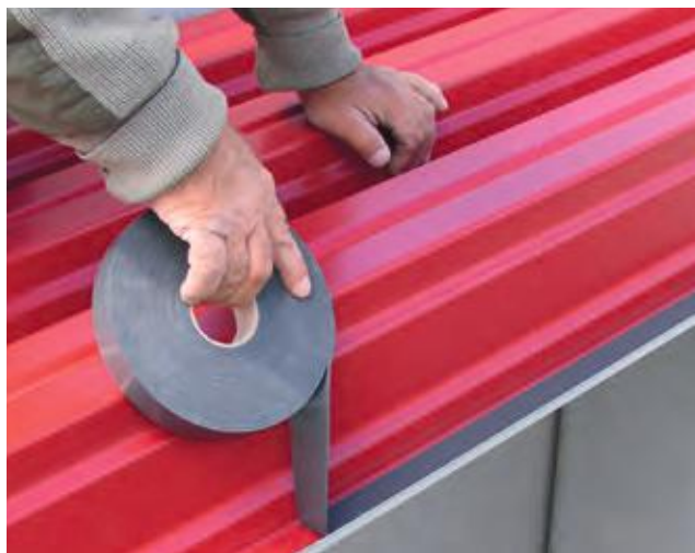
Einbaubeispiel: ISO-ZELL FIXBAND
