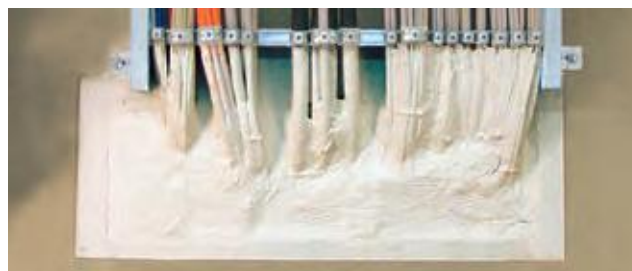
Einbaubeispiel: ISO-FLAME PLATTE S 90
