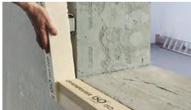
Einbaubeispiel: VORWANDMONTAGESYSTEM ISO-TOP WINFRAMER „TYP 2“
