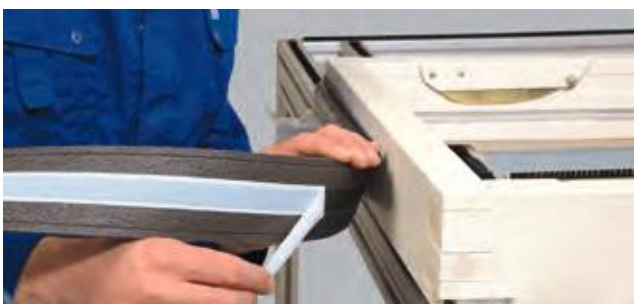
Einbaubeispiel (1-BT): Holzfenstermontage
