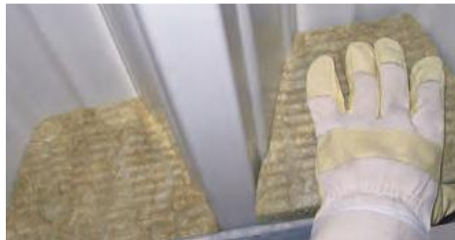
Einbaubeispiel: ISO-PROFIL FÜLLERSTÜCKE
