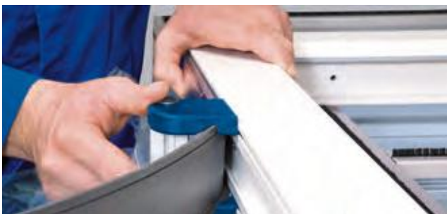
Einbaubeispiel (CB): Kunststofffenstermontage
