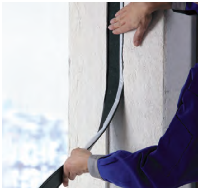
Einbaubeispiel: ISO-BLOCO RENO
