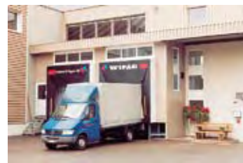
Sanierungen, Umbauten - vorher/nachher
