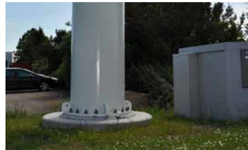
Teknikken kan placeres tæt ved masten og kablerne føres i jorden eller via kabelbro til masten.
