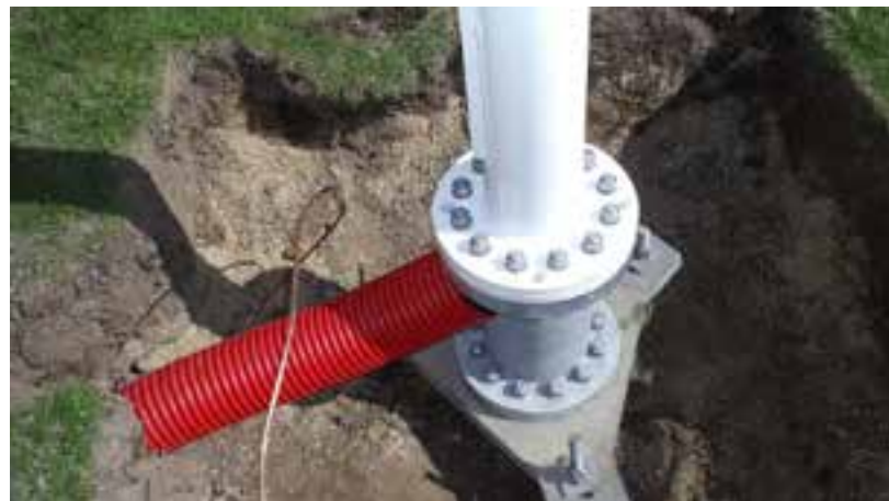
Flagstænger kan monteres på almindelige borede betonfundamenter eller til Screwfast fundament, hvor installationstiden er kortere og reetablering af området lettere.
