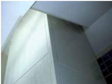
**Abb. 4a:** Schachtverkleidung mit glatten Füllblechen ...
