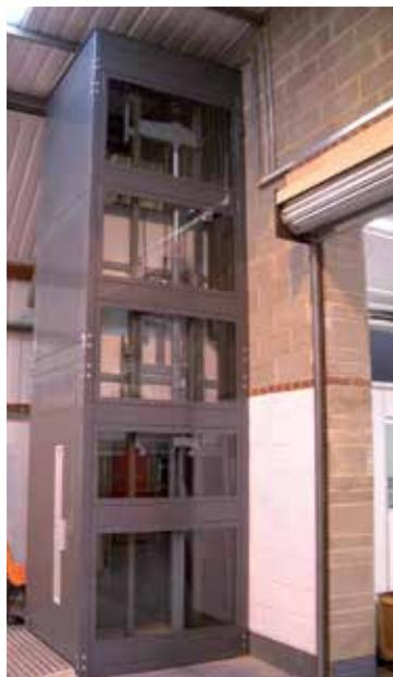
**Abb. 4c:** Schacht mit Glas
