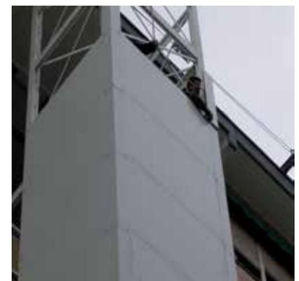
**Abb. 4d:** Schachtverkleidung mit Sandwichpaneelen
