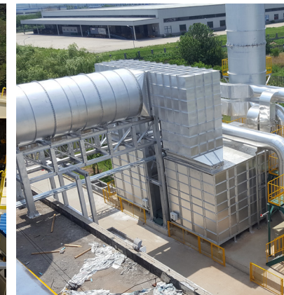
5000 Nm3/min (Concentrator + RTO)
