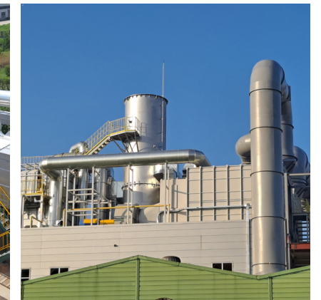
7700 Nm3/min (Concentrator + RTO)
