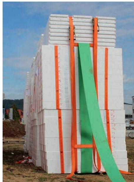
Isolations-Hebegurte mit Ausrutschsicherung beim Anheben. Inklusiv UR3511/25m und 15 Steganschleifen an Hebegurt.
