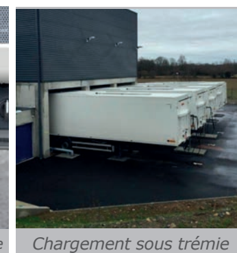
Chargement sous trémie
