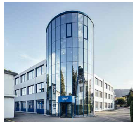
GWF MessSysteme AG in Lucerne CH
