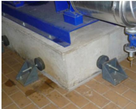
Horizontale Abstützung eines elastisch gelagerten Pumpenfundamentes.
