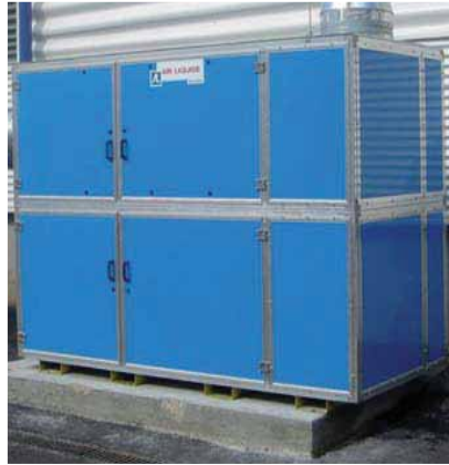
Gamme "COMPACT", 4000 à 12000 m 3 /h, 4 à 12 cartouches filtrantes, version avec fûts à poussières.
