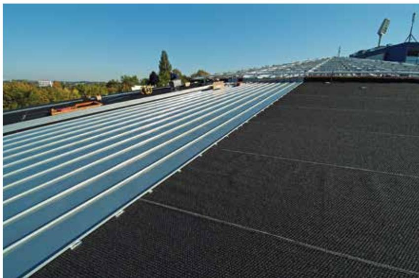
DELTA®-TRELA PLUS als Trennlage bei Metalldeckung.
