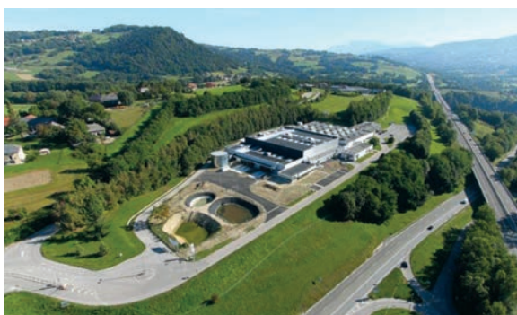
Commissioning et qualification des équipements de production et de conditionnement - Galderma, Alby-sur-Chéran (74)
