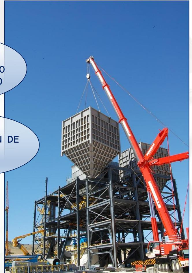
**CONDUCTOS DE GASES PARA TRANSFORMACIÓN DE UN HORNO DE
