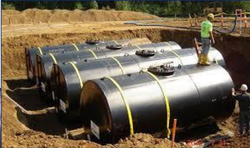
FABRICACIÓN DEPÓSITOS EN ACERO AL
