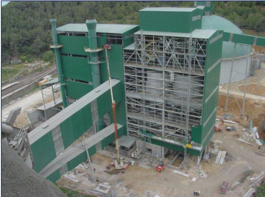
FABRICACIÓN Y MONTAJE DE ALIMENTACIÓN DE KLINKER
