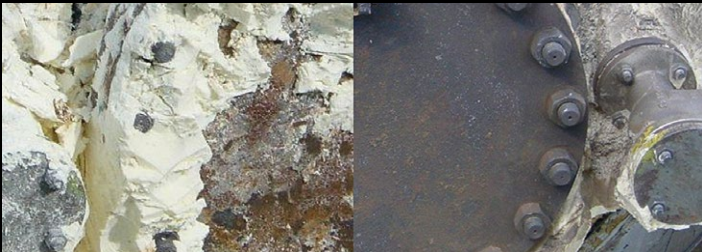
Armaturen und Leitungssysteme, wie sie zum Beispiel in Raffinerien eingesetzt werden, lassen sich mit White Lion Trockeneis-Strahlgeräten perfekt reinigen. PU-Schaum-Rückstände oder eine Vielzahl von Anhaftungen können mit dem Trockeneis-Strahlverfahren rückstandsfrei entfernt werden.
