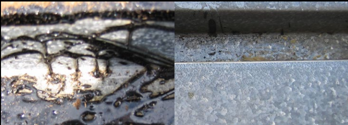
Bitumenbahnen auf Flachdächern müssen nach Brand-schäden häufig ersetzt werden. Aber wie trennt man die geschmolzenen Teerbahnen sauber vom Dach ab? Hier sehen Sie das Ergebnis, das entsteht, wenn man in einem solchen Fall zum Trockeneisstrahlen greift. Das Bitumen reagiert hervorragend auf die Kälteeinwirkung des Trockeneisstrahlverfahrens und platzt regelrecht ab. Die Zinkschicht des Bleches wird nicht abgetragen
