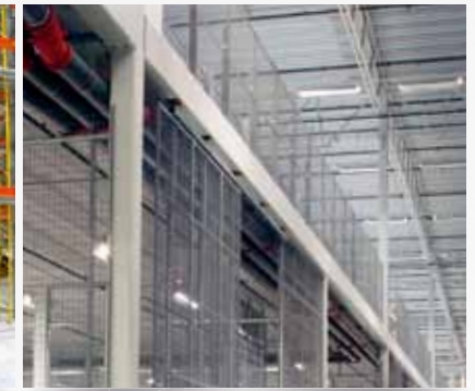
Entresol Avgränsande nätvägg på ett entresolplan skyddar både material och människor från fallande föremål.
