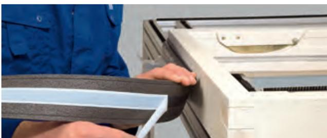
Exemple de mise en œuvre (1-BT) : Montage sur une fenêtre en bois
