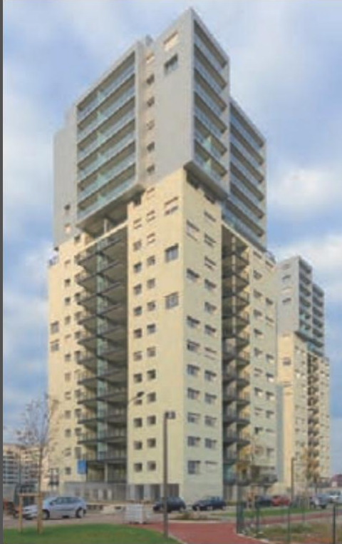
ITALY Torri Residenziali Via Adriano, Milano
