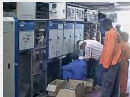
Mozambique ABB - övervakning av installation CGM MVS 36kV
