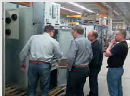
Fabrikstest av AMC MSP på Ormazabal, Tyskland
