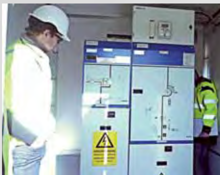
Inspektion av Vindkraft Station 36kV
