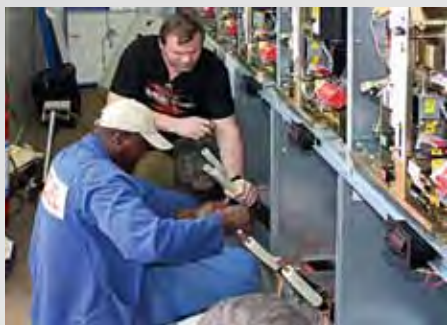
Utbildning av entreprenörer på kabel- avslut 36 kV
