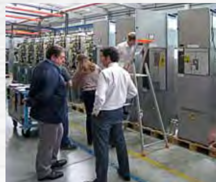
Fabrikstest av CPG MSP på Ormazabal, Spanien
