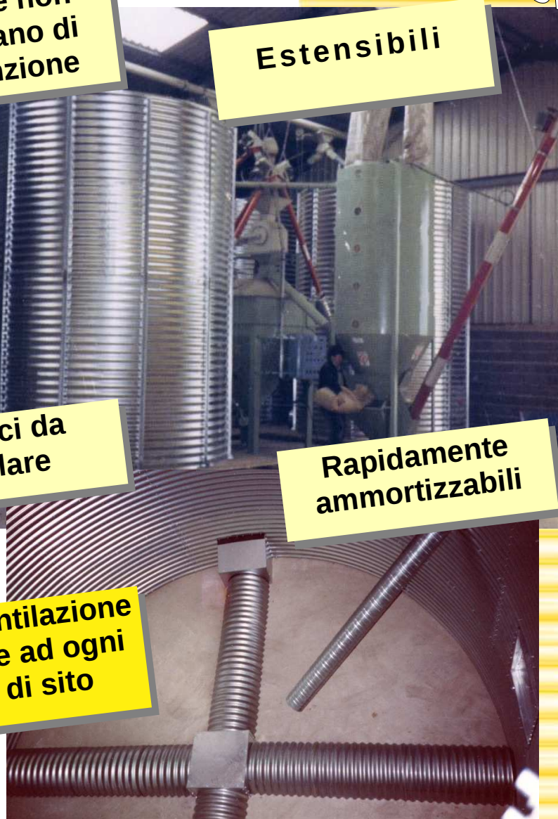
VENTILAZIONE AIRGAINE Entrata Ø 300. Sistema d'estrazione con tubo Ø 200 o Ø 300, permette il passaggio della coclea.
