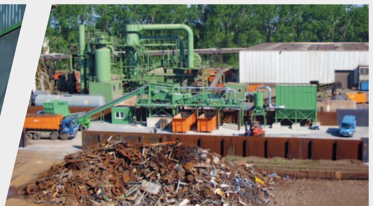
ZENO-Aufbereitungs- und Dosieranlage
