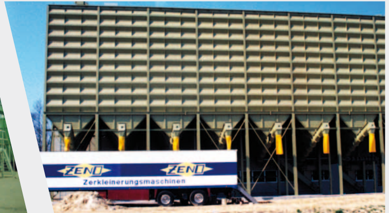
ZENO-Agglomeratsilos Fassungsvermögen 2.000 m 3
