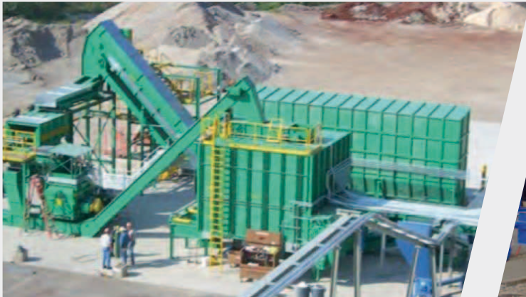
EBS-Aufbereitung im Zementwerk
