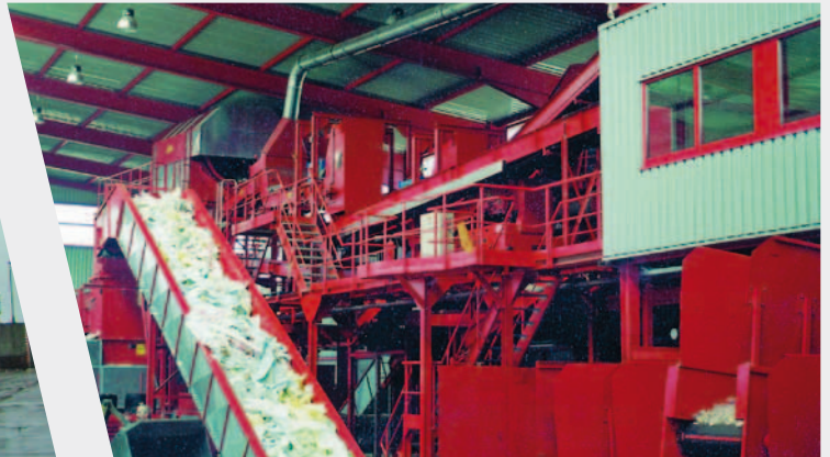
ZENO-Müll- und Papiersortieranlage mit modernster Sortiertechnik
