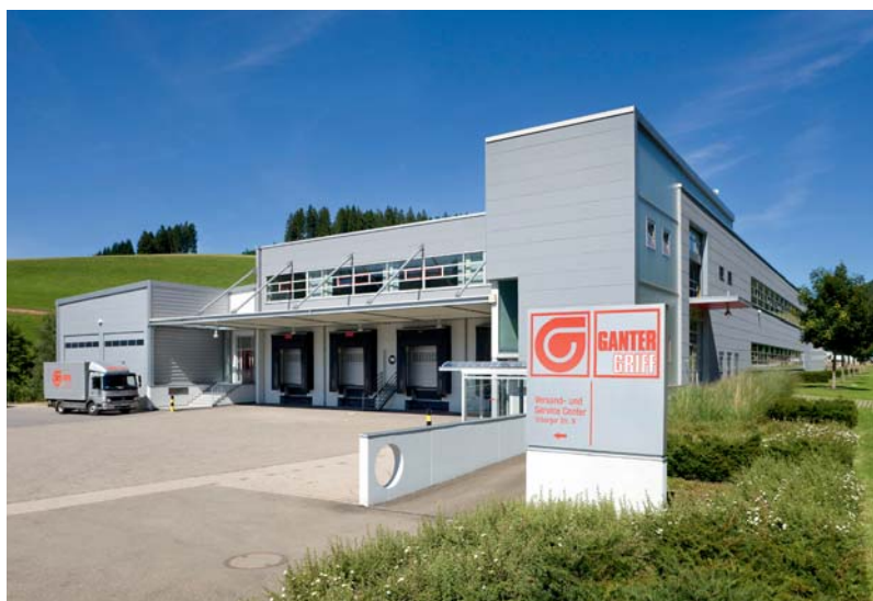
Hlavní sídlo GANTER - Furtwangen, Německo
