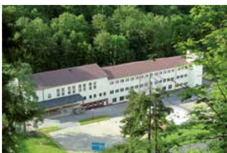
Werk 3 – Unterweißbach Transformatorenbau
