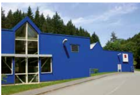
Werk 2 – Mellenbach Elektronikfertigung
