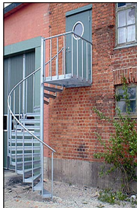
Ohlssons Maskinservice Vingåker, spiraltrappa med räcke i industriutförande, varmförzinkad.
