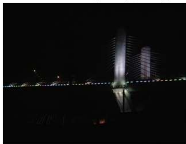
광주광역시 운남대교 UnNam—Large bridge, Gwangju
