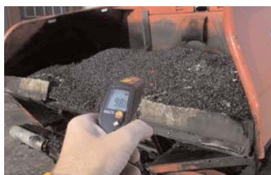
Kontroll att asfalten håller tillräcklig temperatur före läggning
