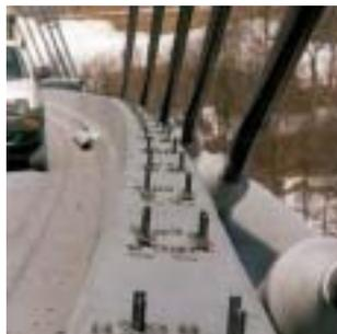
Fixation sans expansion dans des trous forés au diamant
