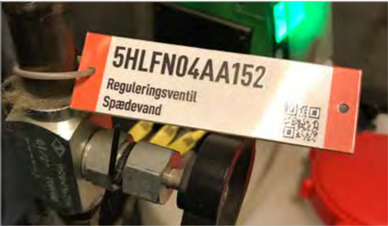
Tagnummer-skyt med mediafärgkod, KKS-kod i text och QR samt klartext
