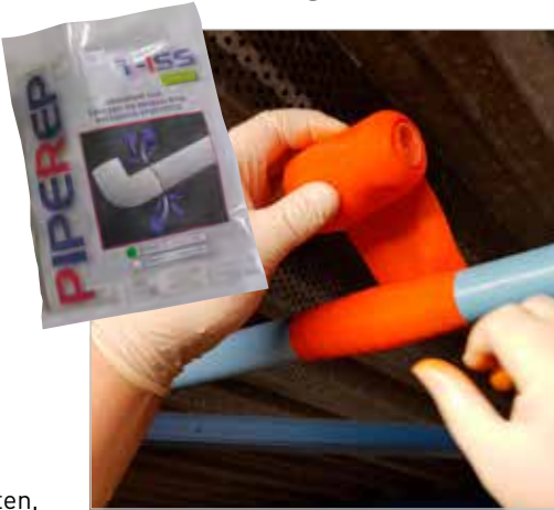
Den blötlagda PipeRep-tejpen viras hårt runt det skadade röret 6-7 varv.
