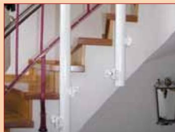
**Wangenbefestigung:** Die Stützen werden an den Innenseiten der Stufen befestigt. Bei einem Rückbau sind Bohrungen in der Wange wesentlich leichter auszubessern als in der Treppe.
