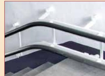
**Wandbefestigung ohne Stützen:** In einigen Fällen ist diese Art der Wandbefestigung (in unterschiedlichen Ausführungen) möglich.
