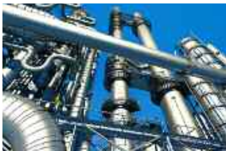
Opérations de nettoyage et d'entretien en production de gaz
