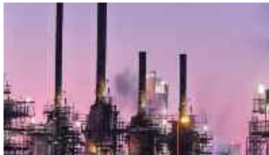
Maintenance générale ateliers de mécanique entretien
