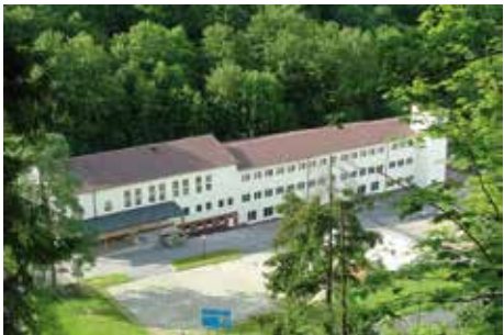
Werk 3 – Unterweißbach Transformatorenbau
