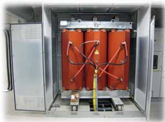
TESAR 1250kVA epoxiisolerad
