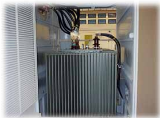
COTRADIS 800kVA oljeisolerad
