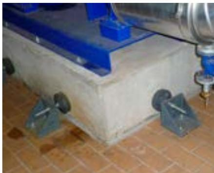
Horizontale Abstützung eines elastisch gelagerten Pumpenfundamentes.
